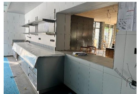
Küche Tagesstrukturen mit Blick in Saal
