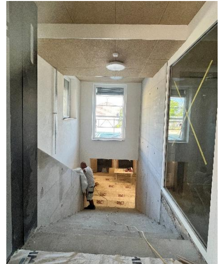
Neu erstellte Treppe ins UG
