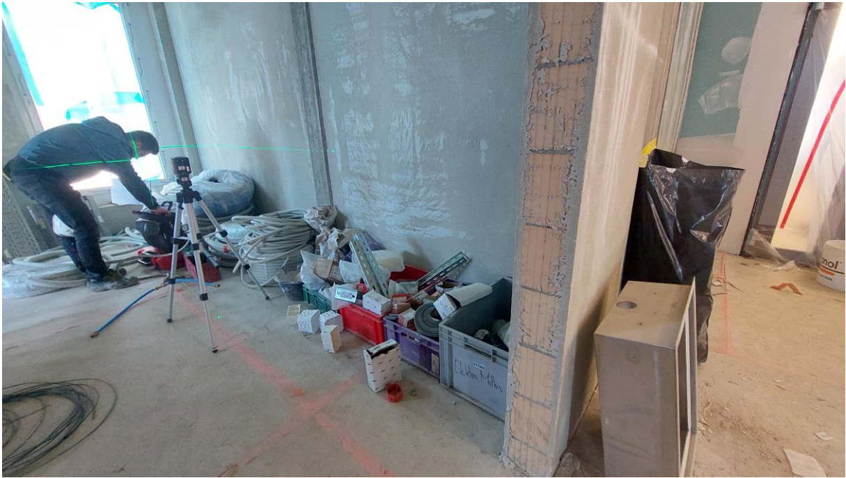
Material zum Verbauen
