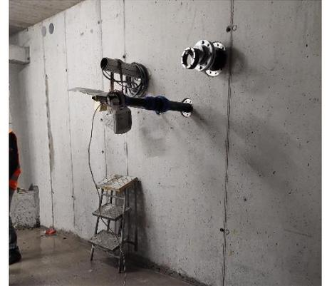
In den Technikräumen stehen die Leitungen bereit für den Anschluss der diversen Anlagen. Hier der Wasseranschluss, Lüftung und einige Stromversorgungen für den Aussenbereich.
