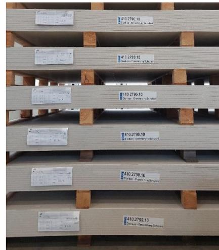
So gestapelt oder eben stehend kommen die Teile dann Laster per Laster an. Wichtig in der Vorbereitung ist, dass genau überlegt wird in welcher Reihenfolge die Teile aufgestellt werden müssen. Genau in dieser Reihenfolge müssen sie auch geliefert werden. Vor Ort ist kein Platz, diese wie ein Puzzle nebeneinander zu legen und auszuwählen welches Teil wohin passt.
