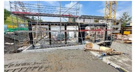
Direkt ab dem Lastwagen werden die Seitenwände des EGs aufgestellt.
