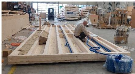
Die Wände schauen so aus. Hier werden bereits die Rohre für die Leitungen verlegt.
