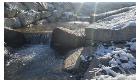
Fertige Schwellen im Dörfli
