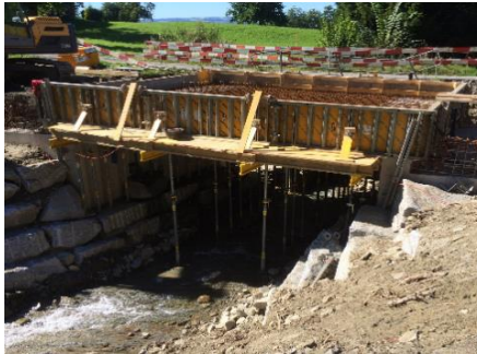
Bau der Brücke Oberdierikon
