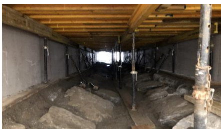
Bau Durchlass Kantonsstrasse
