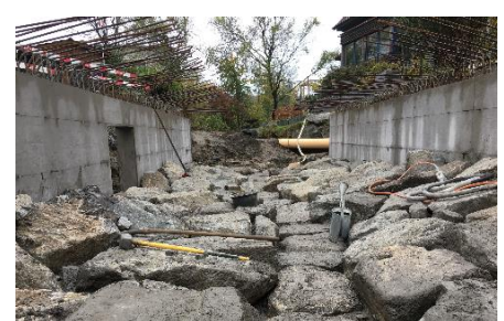
Bau Durchlass Dörfli
