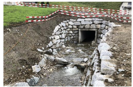
Neuer Durchlass Mühle
