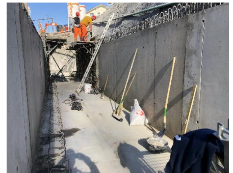
Baustelle hinter der Mühle
