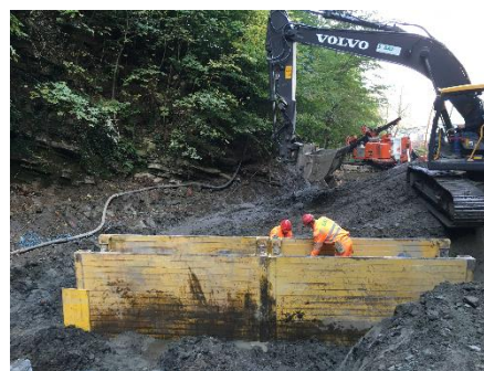
Baustelle hinter der Mühle
