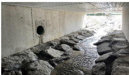
Neuer Bachdurchlass Kantonsstrasse
