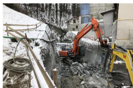
Baustelle hinter der Mühle
