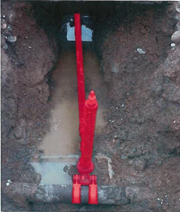
Abbildung 1: Anbohrschieber mit Hausanschlussleitung
