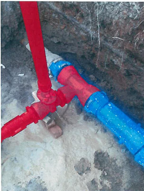
Abbildung 3: Abzweigstück mit Schieber
